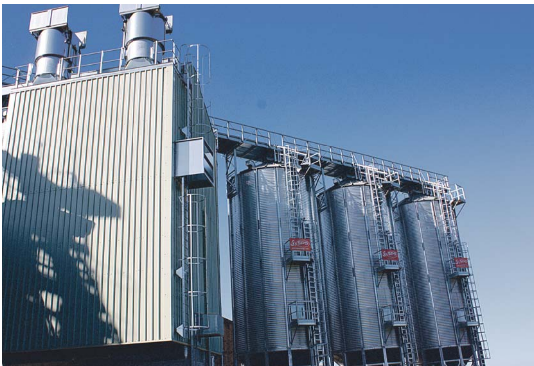
Kuivati töötab ööpäevaringselt, vilja kuivatamise teenust pakutakse laialt, vilja veetakse siia igalt poolt üle Eesti. Vili läheb läbi eelsäilituspunkrite kuivatisse ning siis elevaatoriga järelkuivatuse punkritesse. Väljuva viljamassi temperatuur peab olema 25 kraadi.
